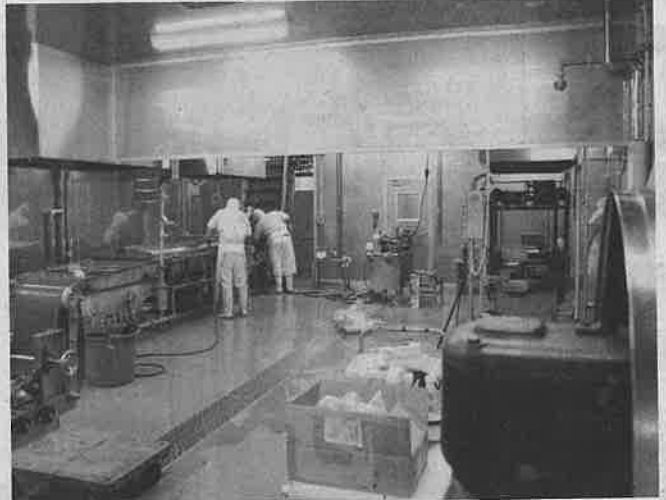
設備の設置を進める新しい第2工場
